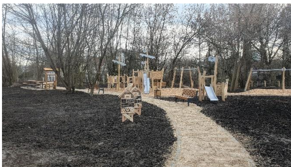
Rysunek 35 Stan robót budowlanych na 29 grudnia 2023 (1).
