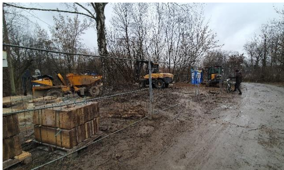
Rysunek 33 Stan robót budowlanych na 20 grudnia 2023 (1).
