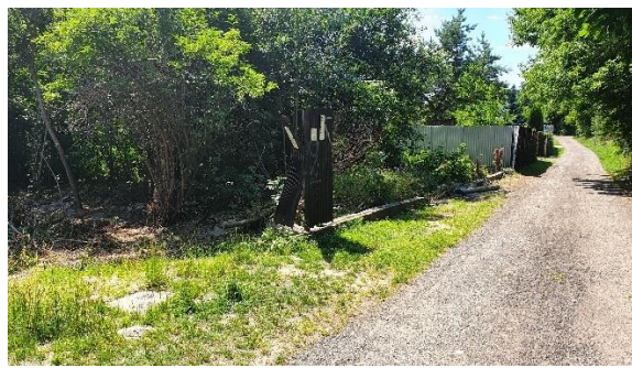
Rysunek 19 Rozbiórka ogrodzenia działki nr 118 w czerwcu 2022.
