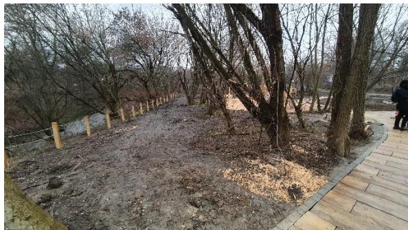
Rysunek 34 Stan robót budowlanych na 20 grudnia 2023 (2).
