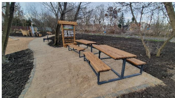
Rysunek 36 Stan robót budowlanych na 29 grudnia 2023 (2).
